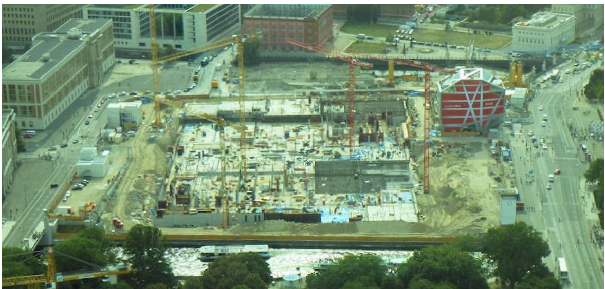
IMAGEM 61: Processo de reconstrução do Berliner Schloss – Humboldtforum no mesmo local, com a Humboldt Box à direita em 2013. O canteiro de obras é parte da exposição deste centro cultural temporário. | FONTE: Claudia Seldin, 2013.
